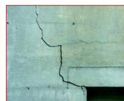
Enduit ciment sur une maçonnerie ancienne : fissurations
