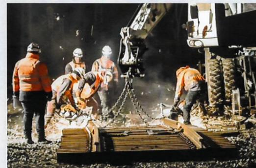
Dépose de la voie par panneaux
